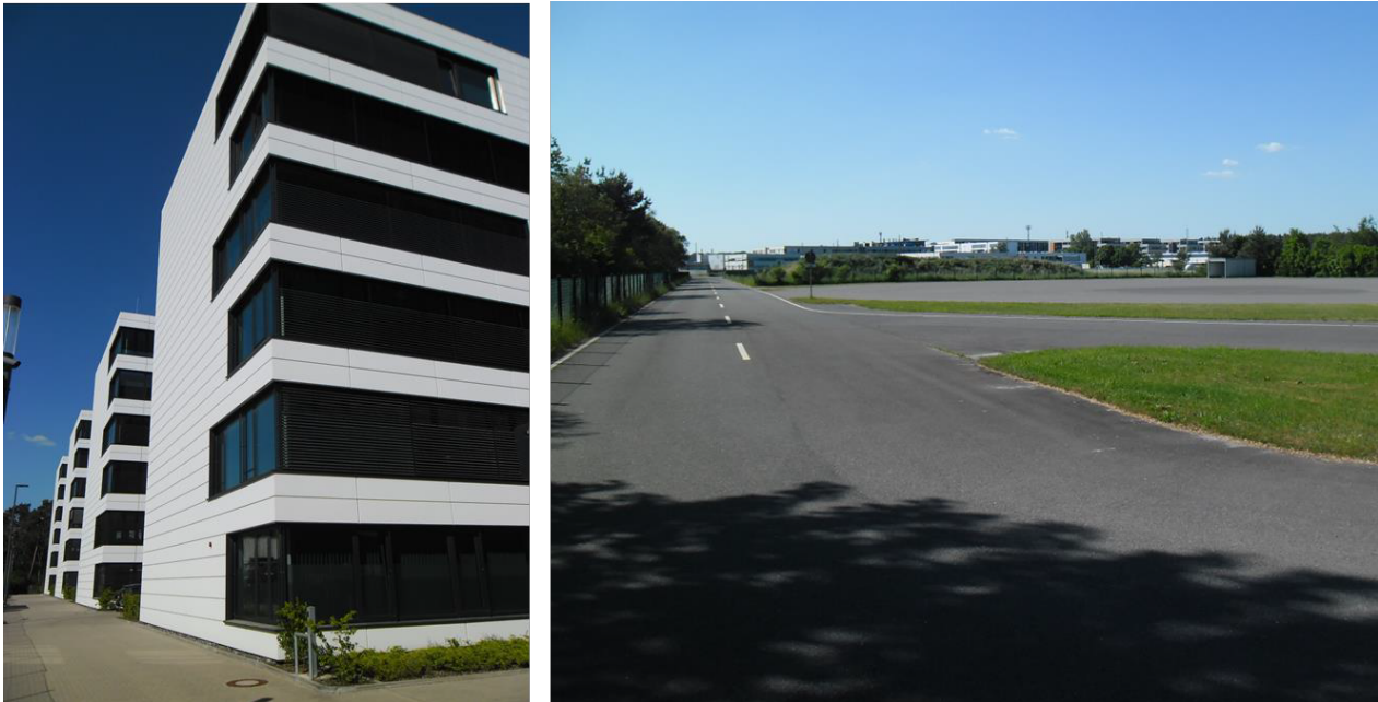
Bild 28. Versuchsorte am IAV-Standort in Gifhorn: Gebäude 5 mit Ansicht auf die Nebengebäude Finger 2 bis 5 (links); Testgelände (rechts)
